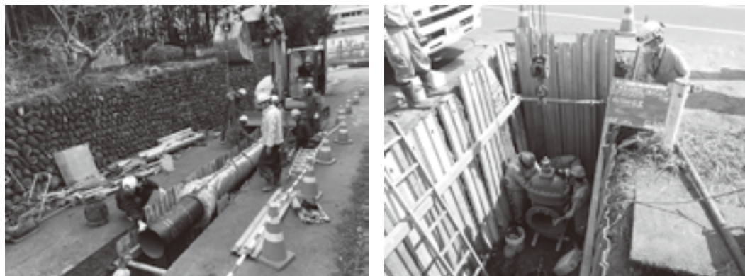
新しい水道管に更新する工事
