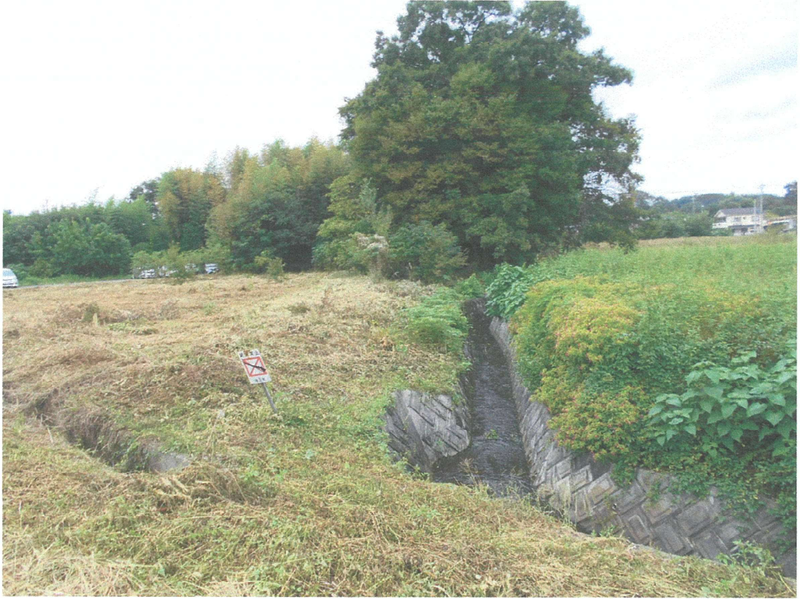
【現況写真 ①】
