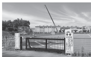
建設中の中央防災倉庫
