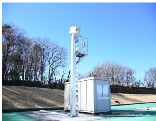
R3 陸上競技場写真判定装置更新
