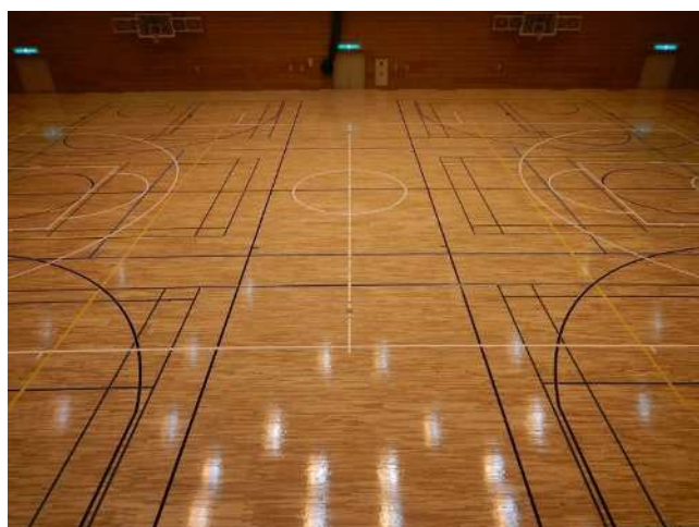
R2 南地区体育館床改修
