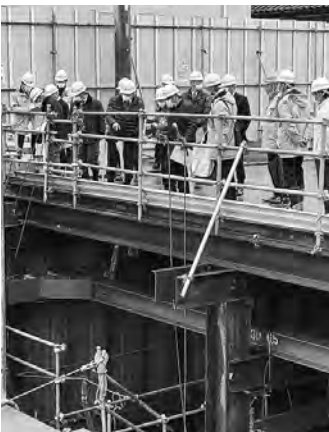
現地視察の様子 R3松高前通線道路築造工事
