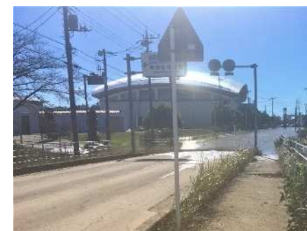
令和元年東日本台風通過後の状況
