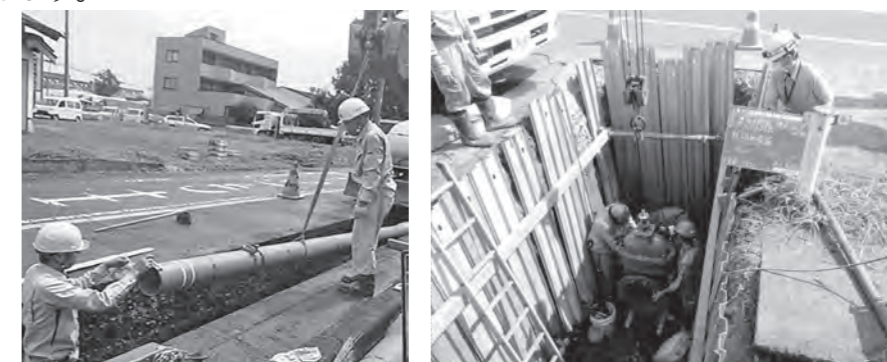
新しい水道管に更新する工事(下唐子地内)
