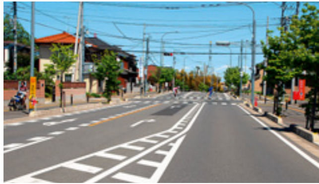
■ 高坂駅東口第一土地区画整理事業 高坂駅東口周辺では、よりよい住環境を目指して、道路、上・下水道、公園などの面的な整備が進められています。
