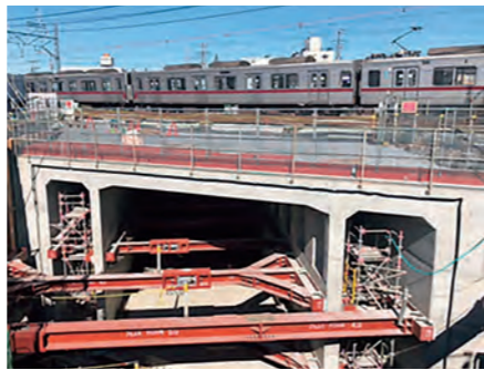
都市計画道路「松高前通線」工事
