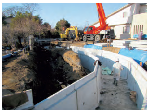
排水路整備工事(下青鳥)
