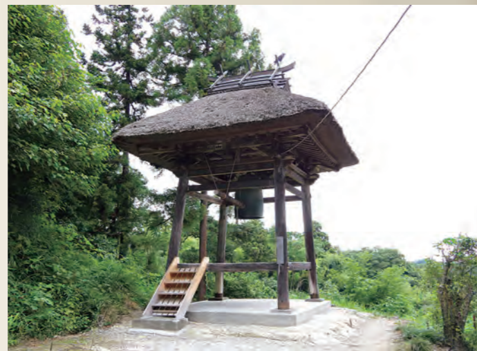
東松山市指定文化財「正法寺の鐘楼」
