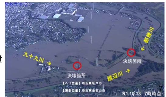
入間川流域における浸水被害状況
