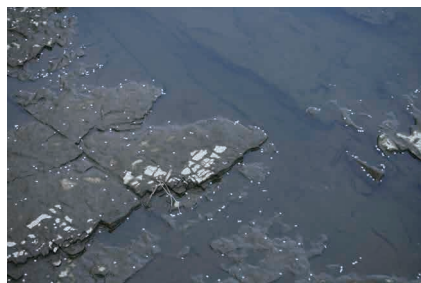
滑川の河床・岩盤が露出している場所が多い
