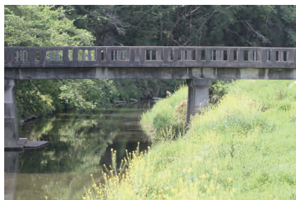
野田地区の下橋・風情ある古い橋
