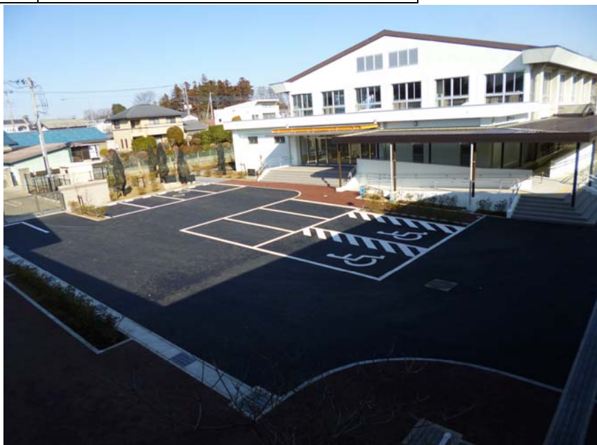
松山第二小学校屋内運動場
