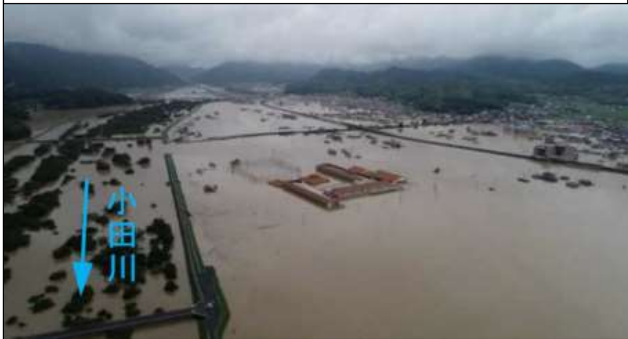
岡山県倉敷市 小田川 (H30年7月豪雨(西日本豪雨))
