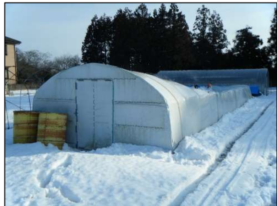
平成26年2月14日・15日大雪 (倒壊したビニールハウス)
