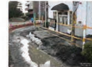
▲東日本大震災での液状化被害 (一財)消防防災科学センター
