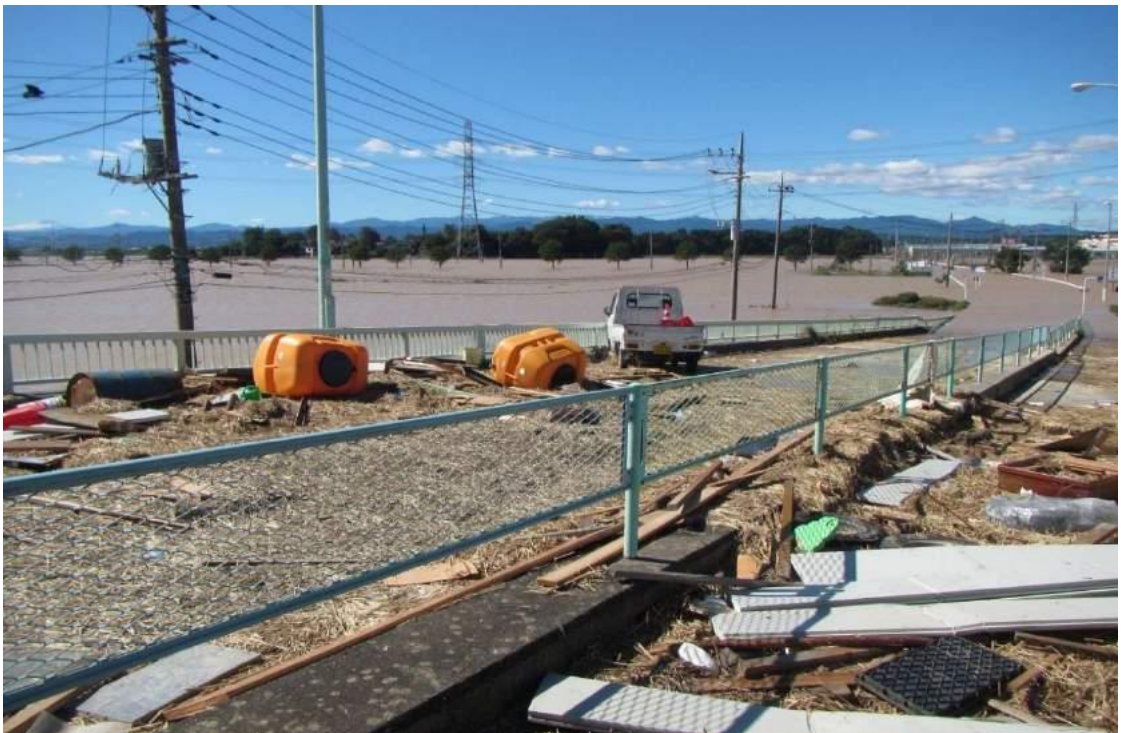
県道岩殿観音南戸守線 早俣橋
