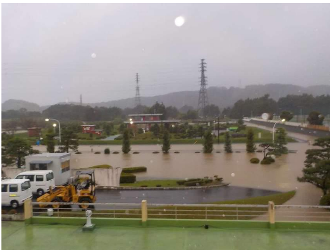
水道庁舎から都幾川方向を撮影
