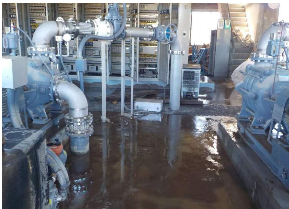
第一浄水場建屋内
