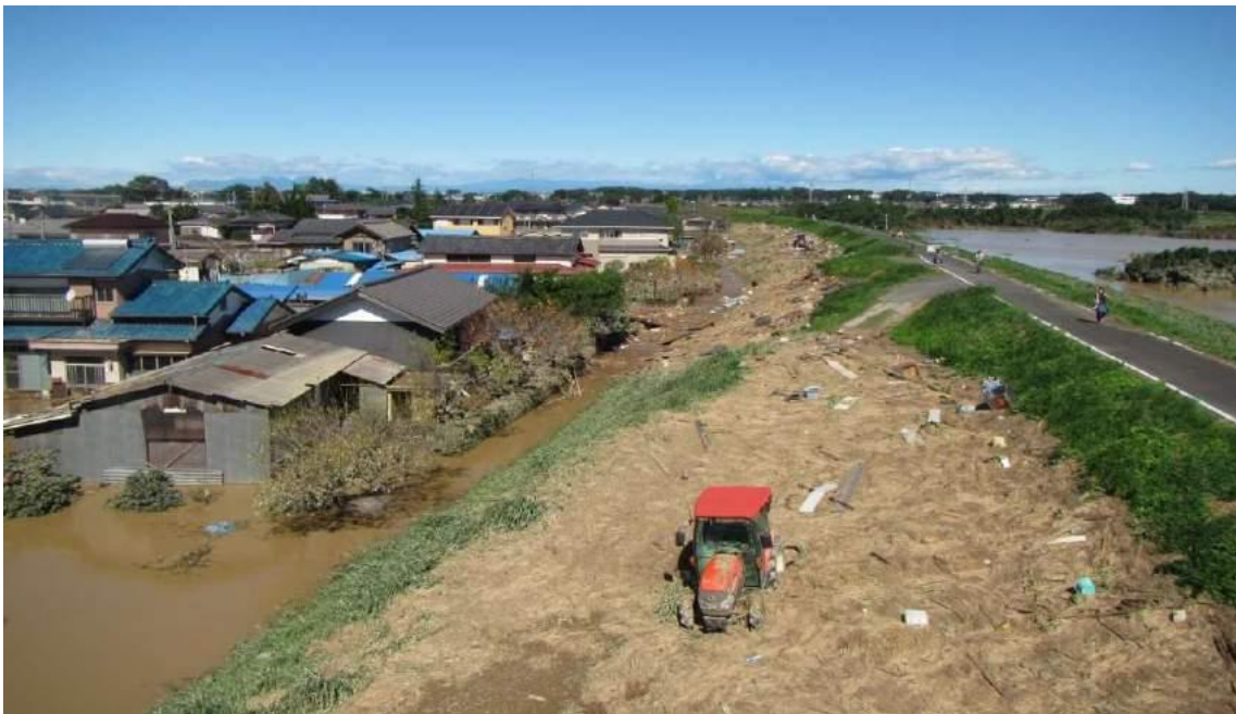
早俣橋（県道岩殿観音南戸守線）から撮影
