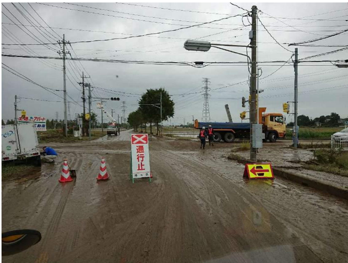
県道岩殿観音南戸守線 早俣橋（西）交差点
