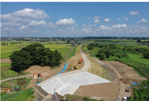
都幾川右岸早俣地先復旧工事状況(R2.8.28)
