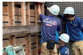
ボルトで固定中
