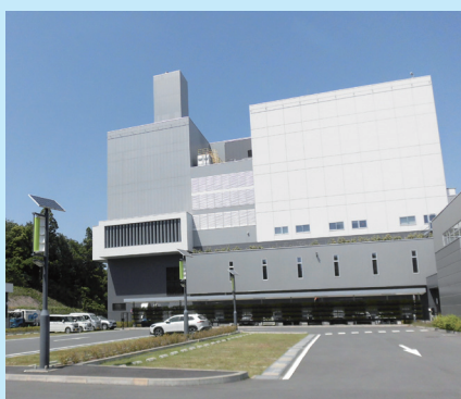
埼玉西部クリーンセンター(鳩山町内)
