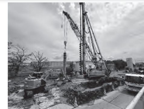
市野川浄化センター塩素消毒設備等更新工事
