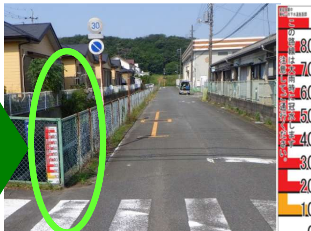
冠水表示板を設置(80cm)
