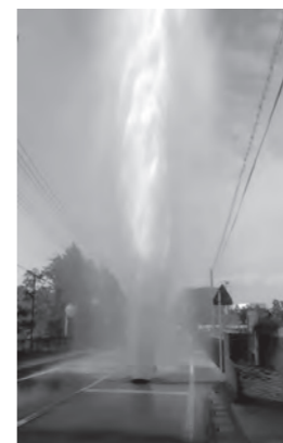
経年劣化による水道管の破損(令和5年 若松町)
