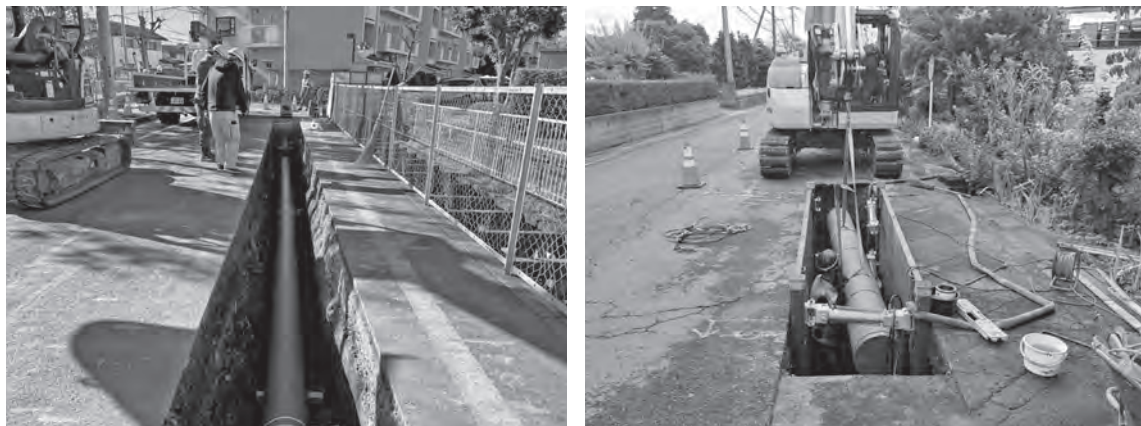
新しい水道管に更新する工事
