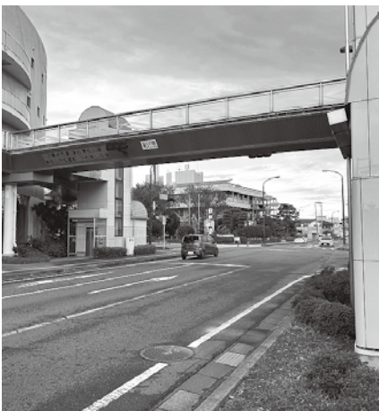
ふれあいの橋
