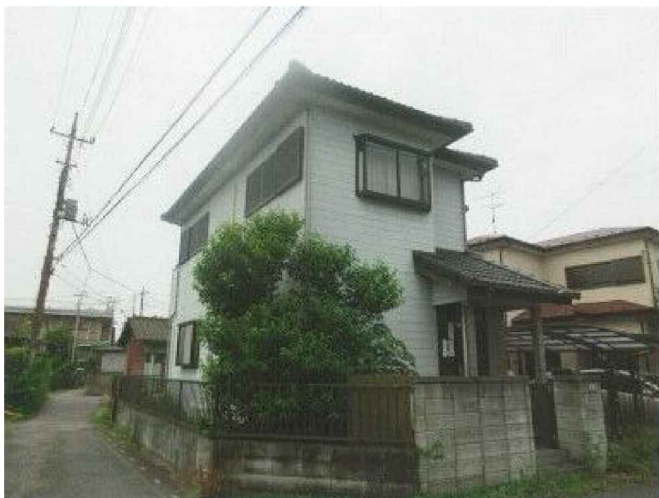
[写真 北東から]
