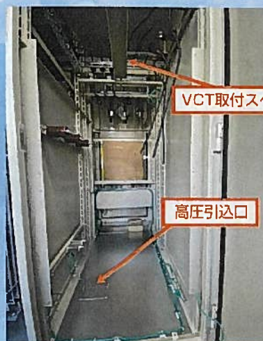
系統連系盤 内部(裏面)
