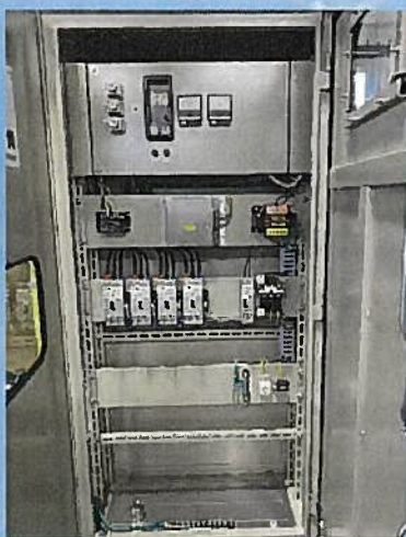
昇圧変圧器盤 内部(前面)
