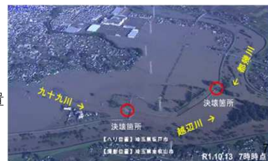
入間川流域における浸水被害状況
