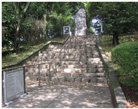
忠魂碑階段中央に手摺を設置
