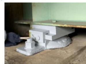
＜対策例＞塗装塗替え工
