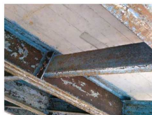
主桁・横桁・支承部の腐食,防食機能の劣化
