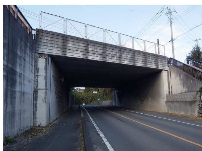
白坂陸橋（健全度Ⅱ）
