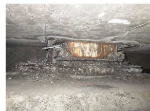
主桁・横桁・支承部の腐食,防食機能の劣化
