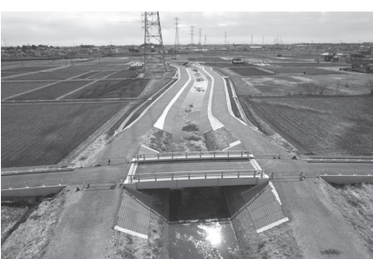
準用河川新江川・完成区間
