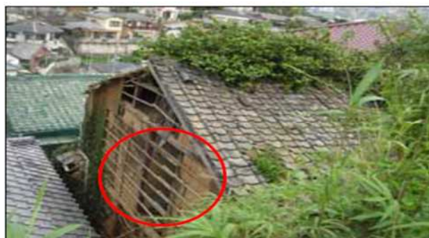
外壁が剥落し、著しく下地が露出するとともに、 壁体を貫通する穴を生じている例（評価点 2 5）
