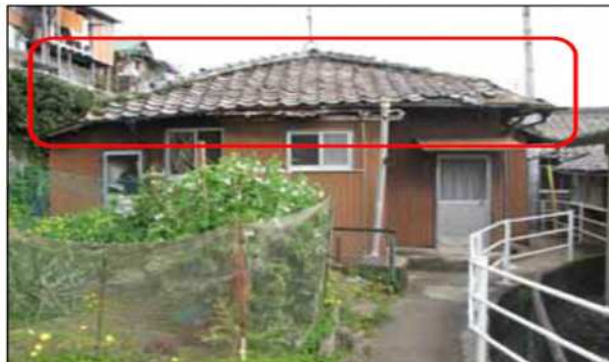
屋根に不陸（凹凸）がある例（評価点 5 0）
