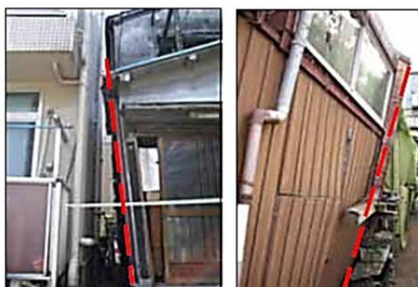
柱の変形が著しく崩壊の危険がある例（評点100）
