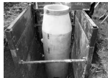
マンホール (下水道管の維持管理をするための施設)
