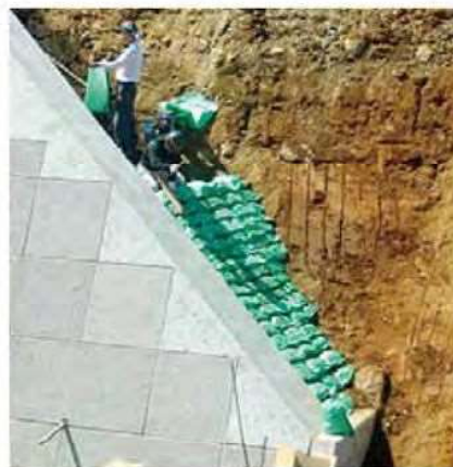
擁壁裏の土砂流出防止
