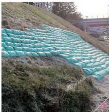
法面崩壊部分の埋戻し
