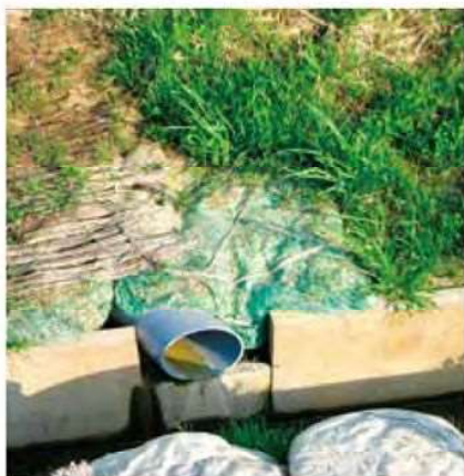
湧水箇所の崩壊防止
