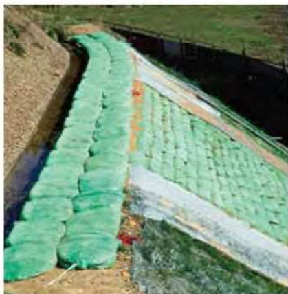
法面崩壊部分の埋戻し
