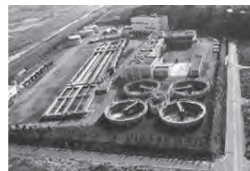
昭和52年 市野川終末処理場完成（現 市野川浄化センター）
