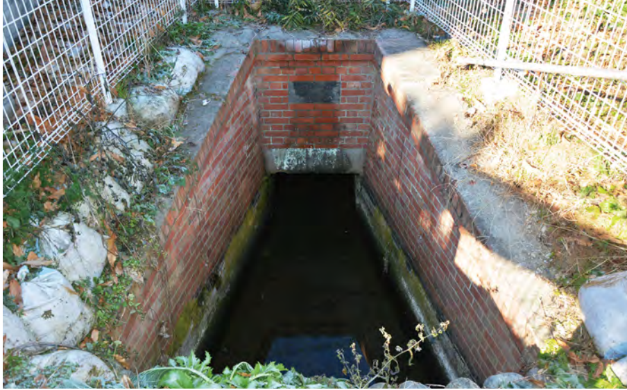
レンガ樋管（永傳樋管）
